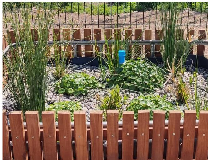
Implementación de una Planta de Tratamiento de Aguas Grises (PTAG), en la cual se considera un sistema de captación, de tratamiento y de disposición de las aguas grises generadas en los baños de cada escuela, conectado a un sistema de riego para abastecer sus principales áreas verdes.
